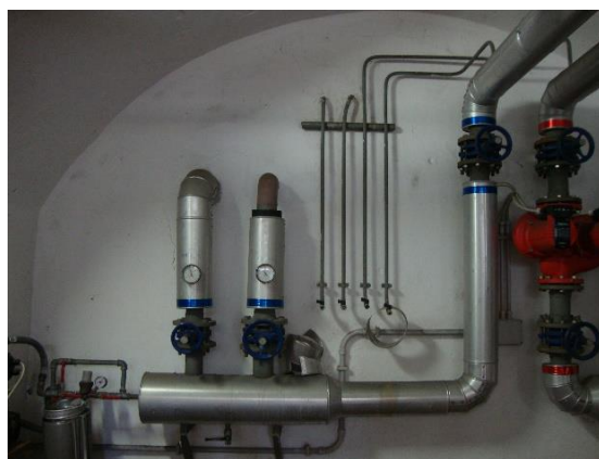
Figura 4.8 - Termostati fluidi di ritorno
