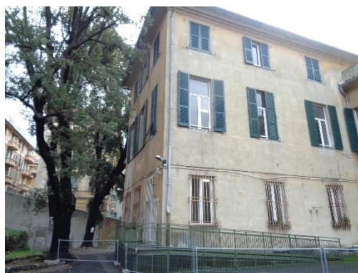
Figura 8.1 - Particolare muratura esterna
