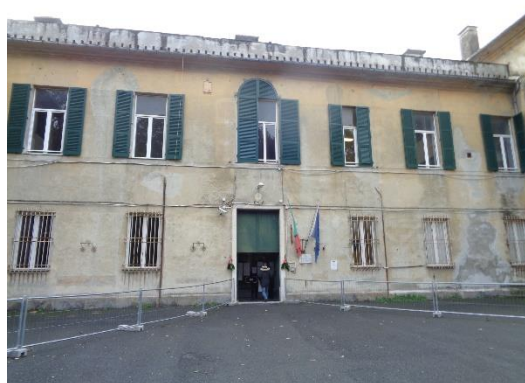
Figura 1.1 - Vista della facciata esposta a Nord-Est
